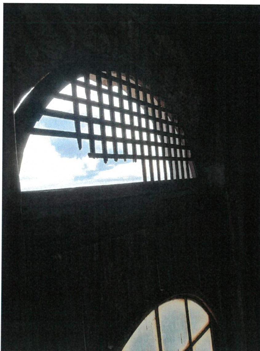
fotografia nr 3 - Stolarka – wybrakowane wypełnienie ażurowe otworu
