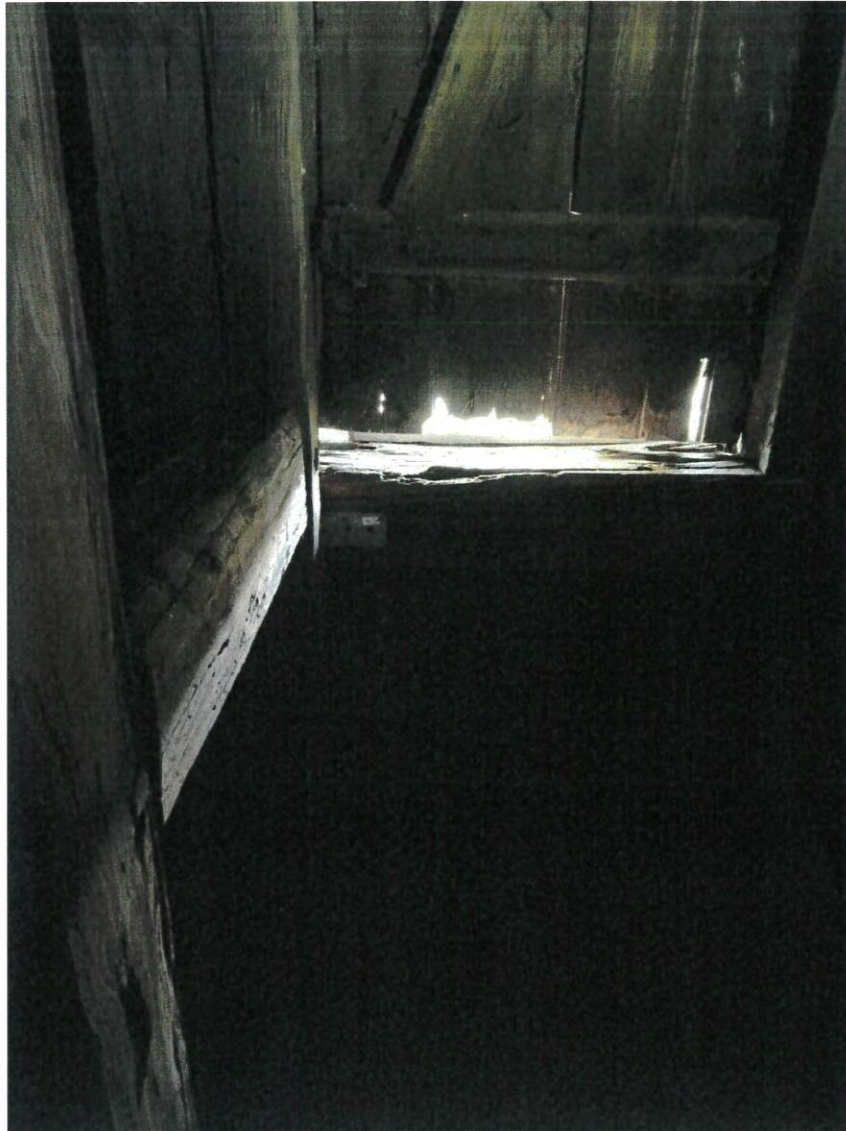
fotografia nr 3 - Stolarka – skorodowane końce desek wypełnienia
