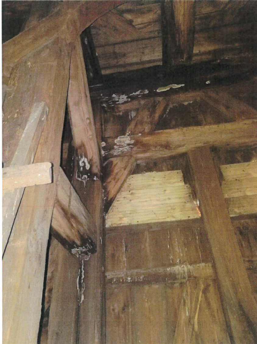
fotografia nr 4 – ślady zaciekającej wody oraz współcześnie wykonane naprawy poszycia wieży
