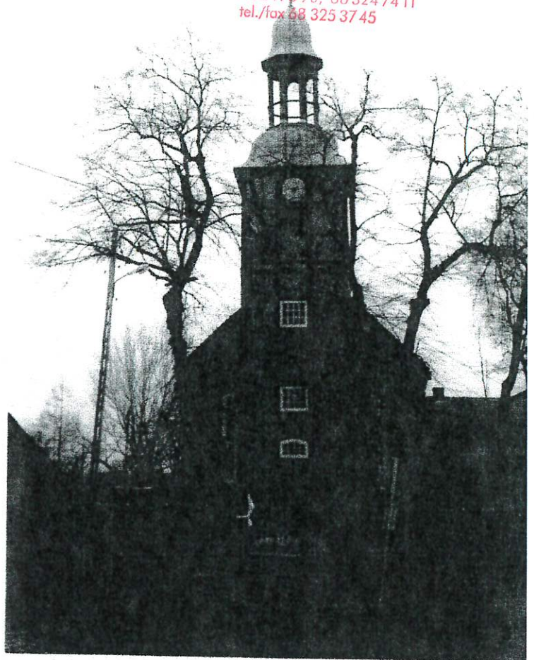
FOTO NR.1.widok od strony wschodnio-południowej widoczne przemieszczenie trzonu wieży w kierunku południowo-zachodnim.
