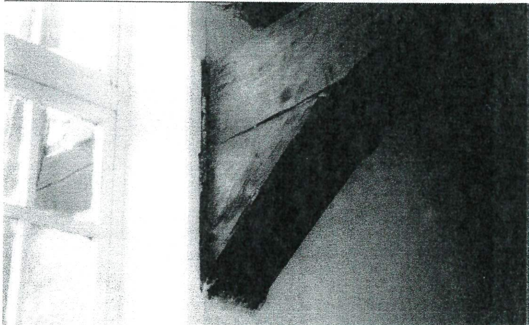
FOTO NR.28.węzeł ciesielski łączący podciąg balkonu z elementami konstrukcyjnymi w
