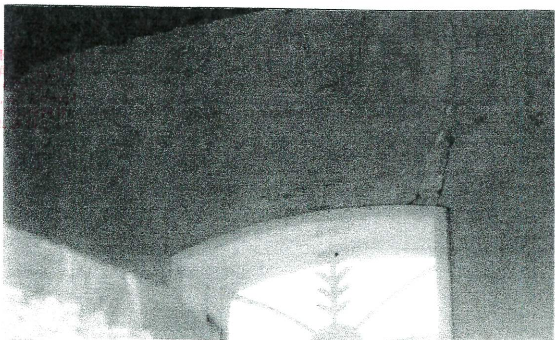
FOTO NR.32.widok na ścianę szczytową zachodnio-północną, widoczne zarusowanie
