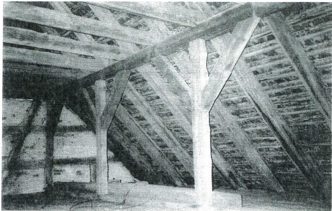
FOTO NR.37.wieżba dachowa systemu jętkowego,u dołu belka nadciągowa stropu
