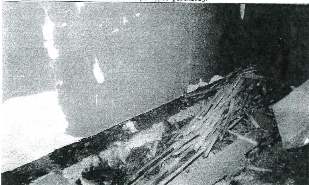
FOTO NR.31.całkowity rozkład podwaliny spowodowany rozwojem czynników biotycznych w tym rozwojem bakterii gnilnych, strefa południowa budynku kościoła.
