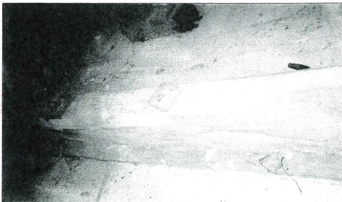
FOTO NR.39.widoczny nadciąg dla belek stropowych,korozja spowodowana żerowaniem larw cwadów
