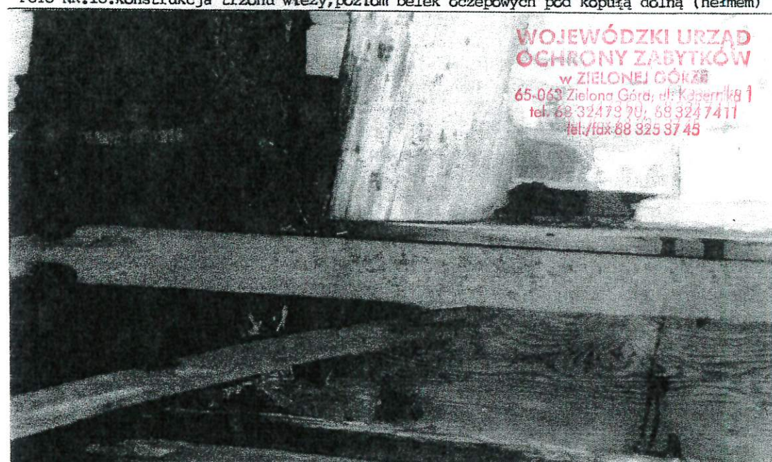
FOTO NR.18.naróżnik południowy wieży, poziom jętek więźby dachowej, widoczne kłamrowanie (ściągi) ścian wieży wprowadzone w trakcie eksploatacji obiektu
