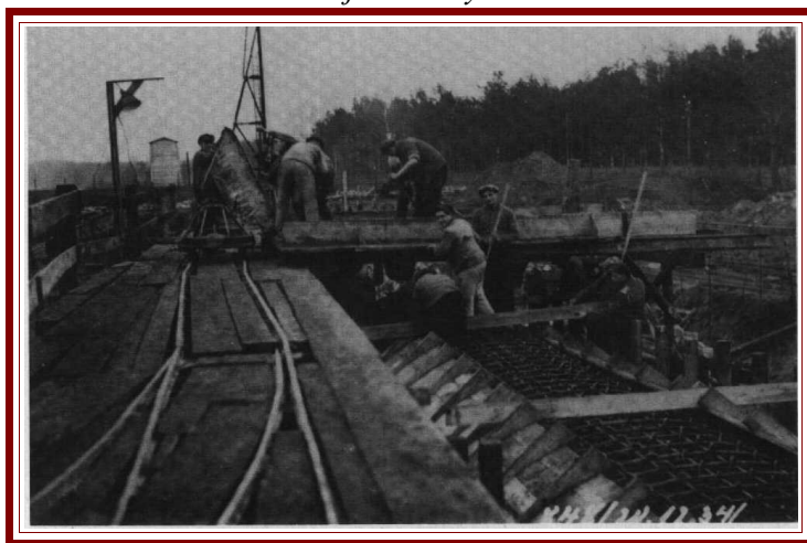
Budowa rampy wyladowczej przy bocznicy dla „Tellagu” blisko stacji Radoszyn
